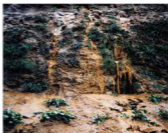
图 6.17 暴雨径流冲刷坡面
