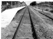
B. 铁轨铺在枕木上
