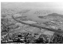
②西九龙填海工程
